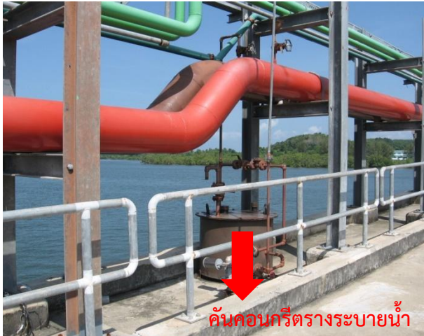
รูปที่ ข.1-4 คั่นคอนกรีตสูง 15 เซนติเมตร ขนานไปกับแนวท่อบนสะพานท่าเทียบเรือ และบ่อพักน้ำที่รวบรวมน้ำฝนบนเรือน้ำมัน
