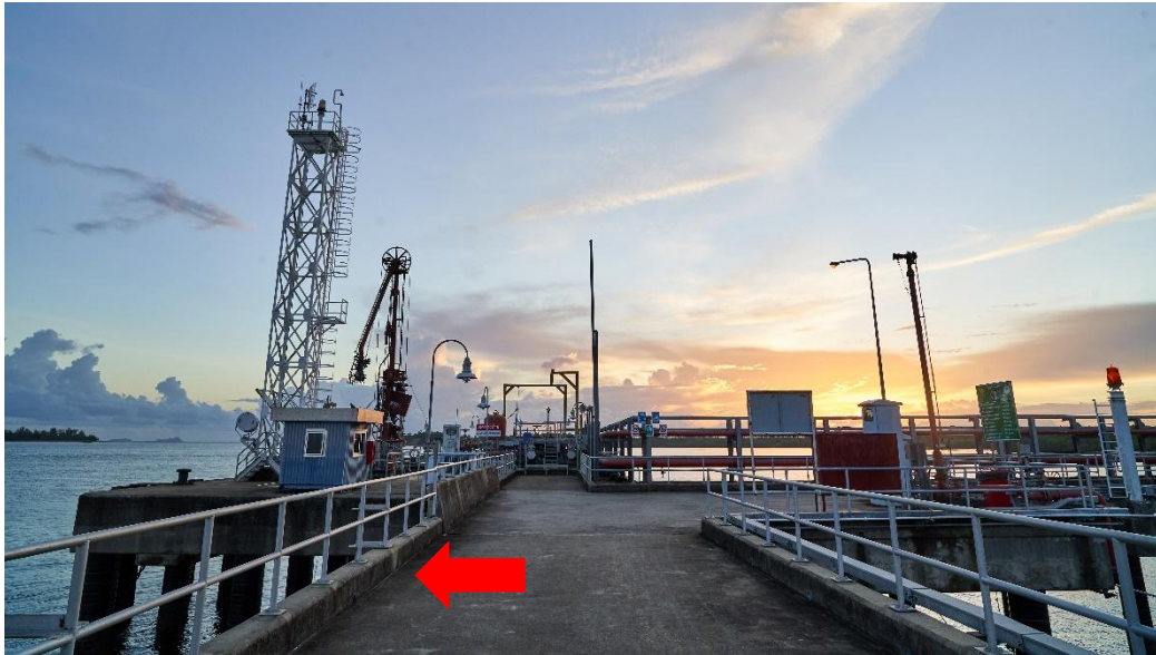
รูปที่ ข.1-9 คั่นคอนกรีตสูง 15 ซม. โดยรอบบริเวณหน้าท่าเทียบเรือ เพื่อให้ น้ำฝนที่ตกลงมาบนดาดฟ้าท่าเทียบเรือไหลไปยัง Drain Pit และส่งน้ำมันไปบำบัดในระบบ Oil-Water Separator
