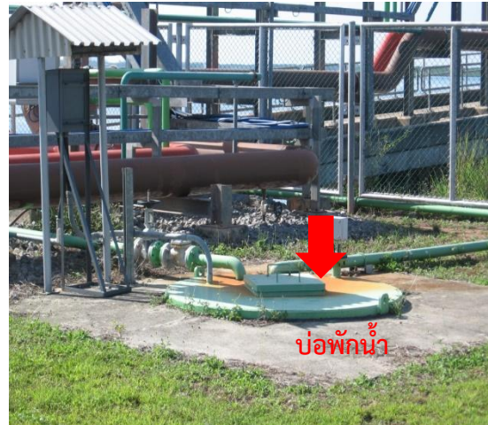
รูปที่ ข.1-4 คั่นคอนกรีตสูง 15 เซนติเมตร ขนานไปกับแนวท่อบนสะพานท่าเทียบเรือ และบ่อพักน้ำที่รวบรวมน้ำฝนบนเรือน้ำมัน
